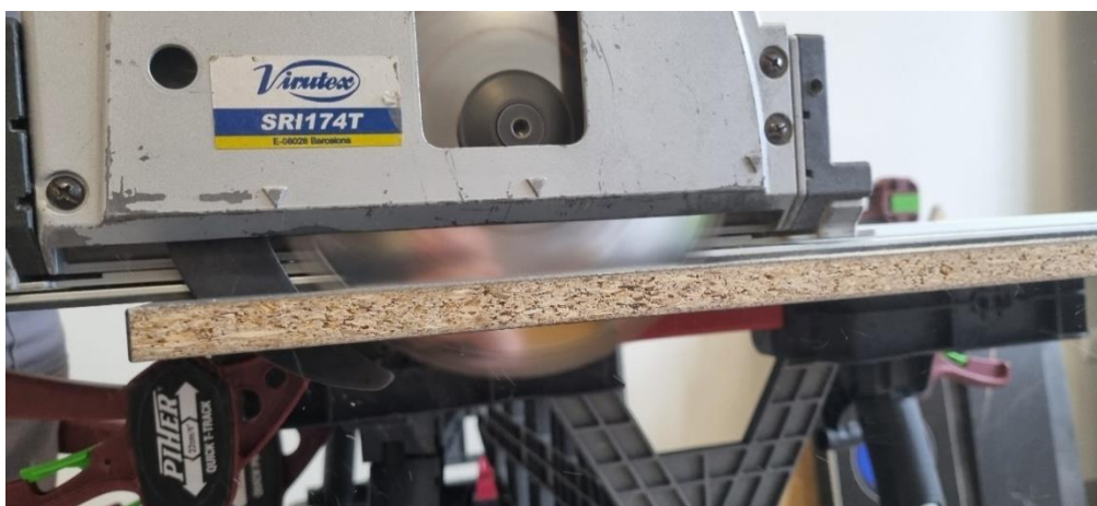
Zdj. 1: Piłowanie (cięcie) płyty – przy użyciu zagłębiarki
