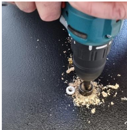
Zdj. 7: Wiercenie otworu pod mufy
