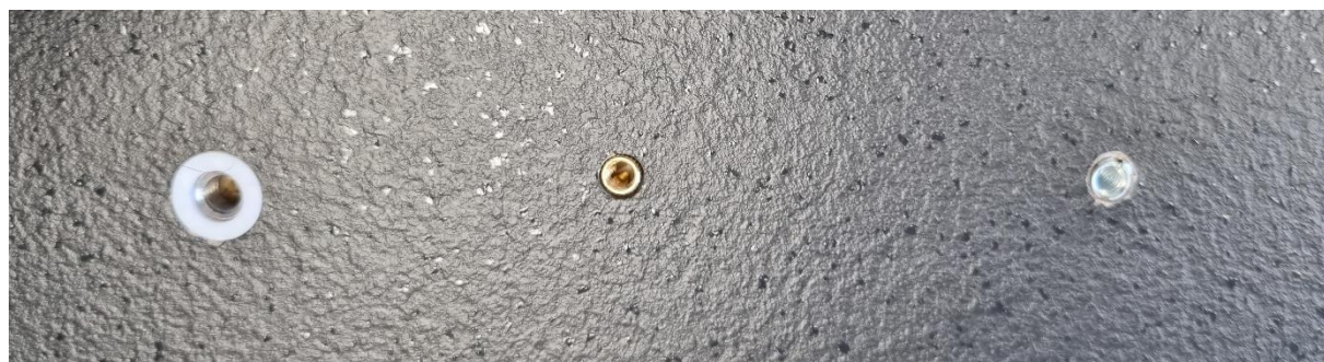
Zdj. 9: Osadzone mufy w wcześniej wywierconych otworach
